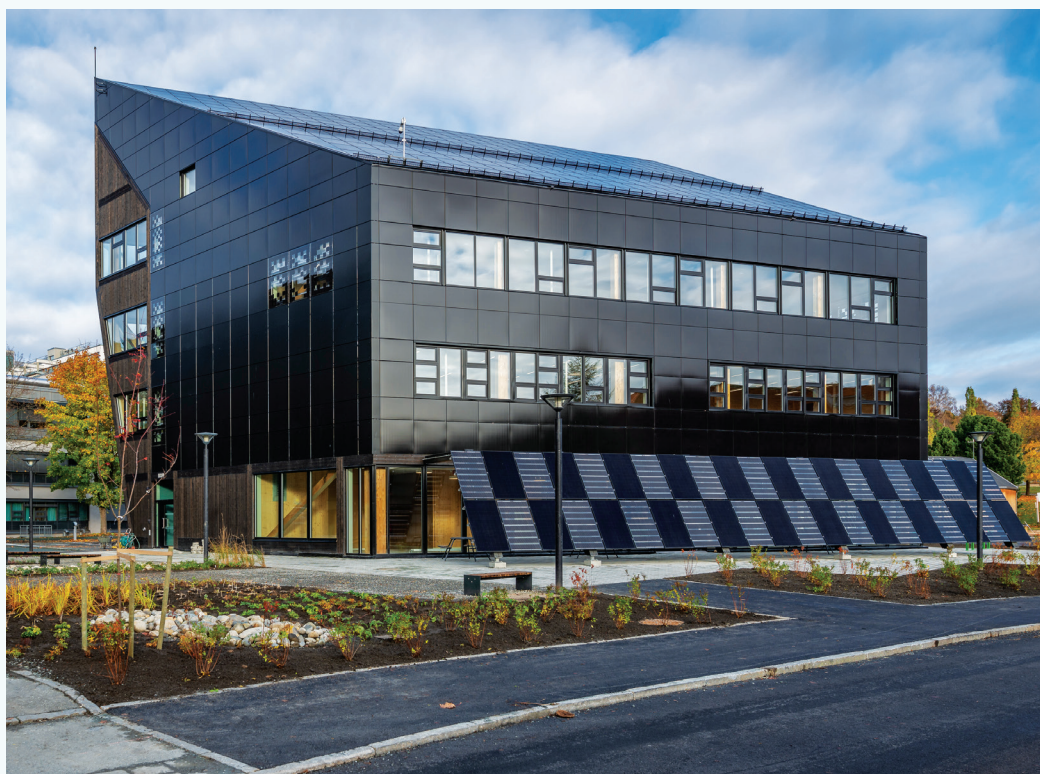
ZEB-laboratoriet er rigget for å samle så mye solenergi som mulig, men nabobygninger, vegetasjon, lysmaster og topografi reduserer potensialet. Å forutsi denne type tap er viktig når en skal bygge effektive solcelleanlegg.
