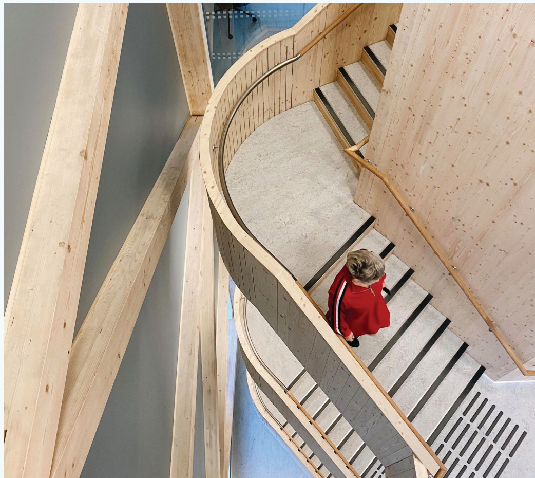
Nullutslippsbygninger bygges typisk med bærekonstruksjon i limt trevirke, noe som kan påvirke inneklimate spesielt i den første tiden etter ferdigstillelse. Foto: Lindbak.
